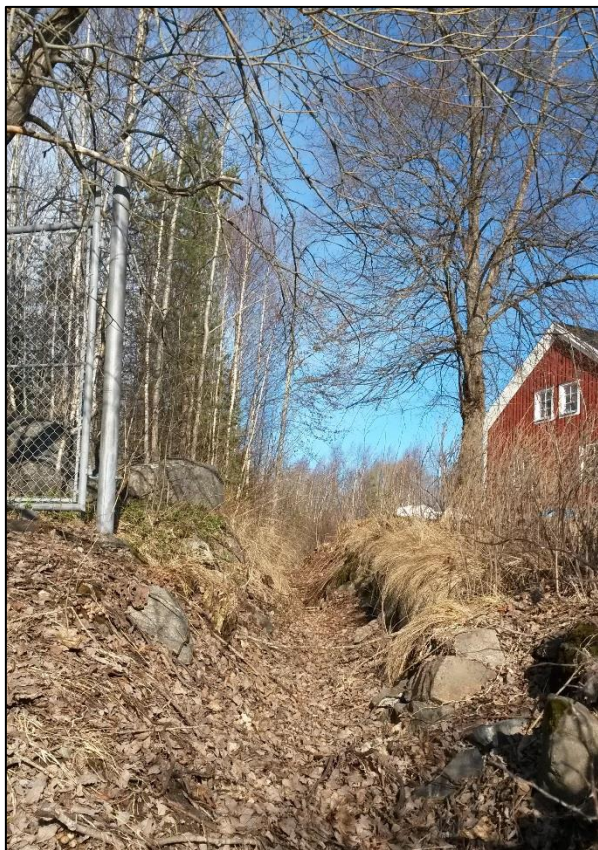
Figur 7. Dike vid fastighetens sydöstra hörn.
